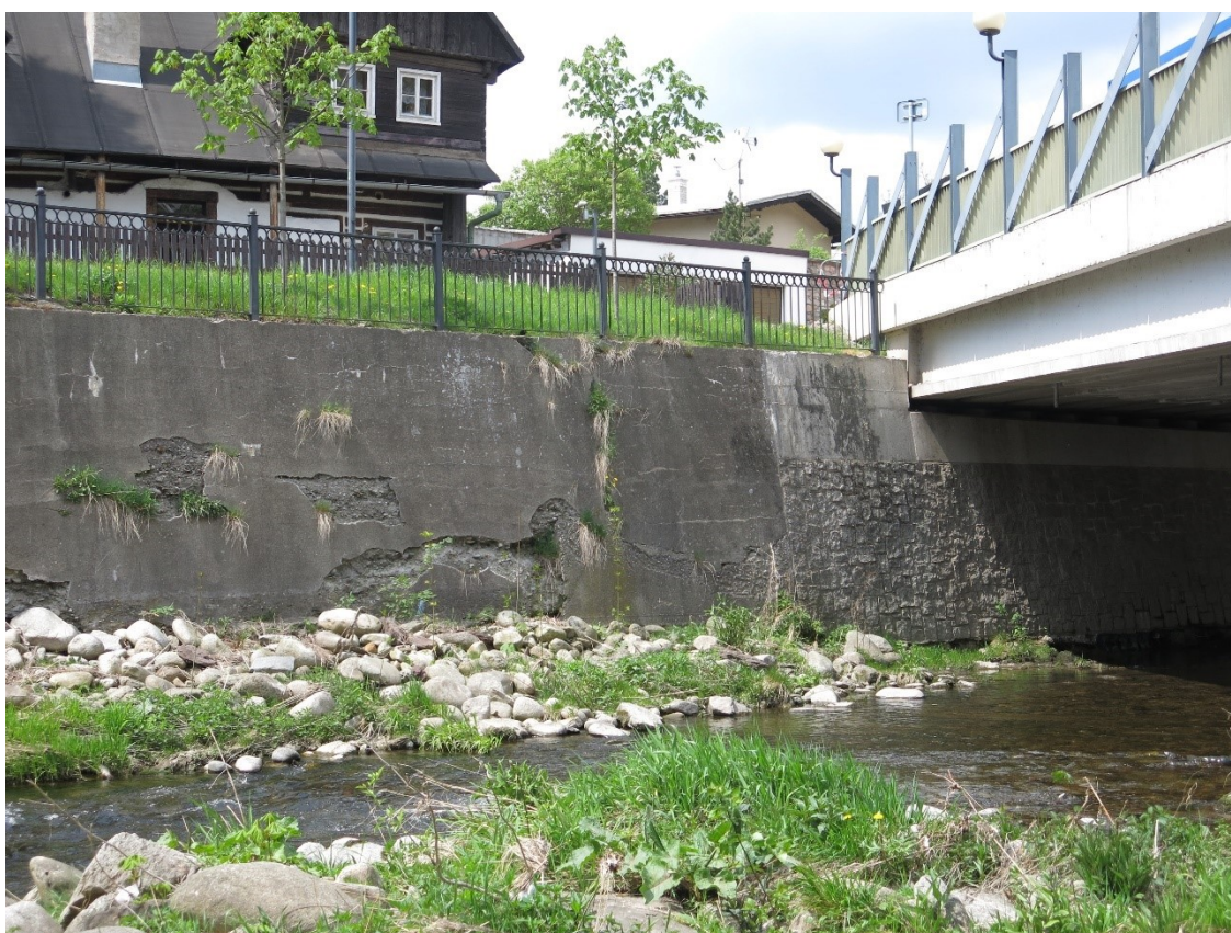
Obrázek 6: Konec úseku, pohled proti proudu. Konec úseku je definován příčnou spárou mezi pilířem silničního mostu a pravobřežní zdí. Foto z května 2017
