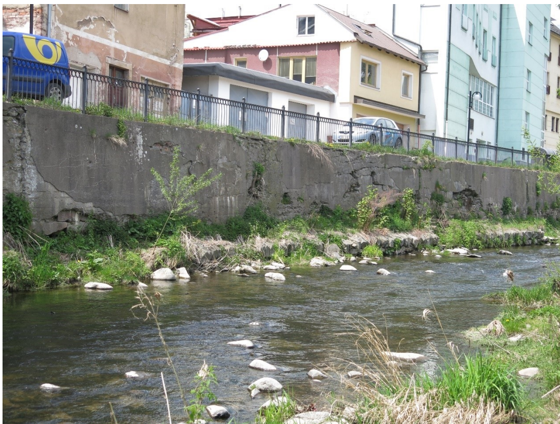
Obrázek 2: Pohled proti proudu na PB toku. Patrné plošné poruchy a trhliny líce břehové zdi. Foto z května 2017
