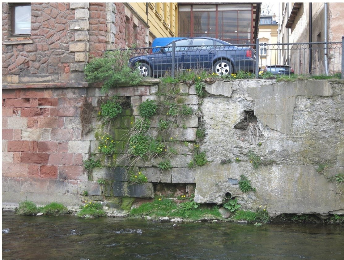
Obrázek 1: Začátek úseku – roh budovy pošty a přechod mezi zdí z pískovcových bloků a betonem. Foto z května 2017
